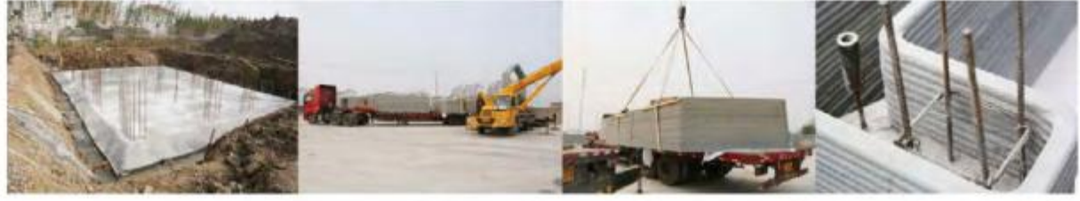
打好地基 运输 吊装 局部灌注
