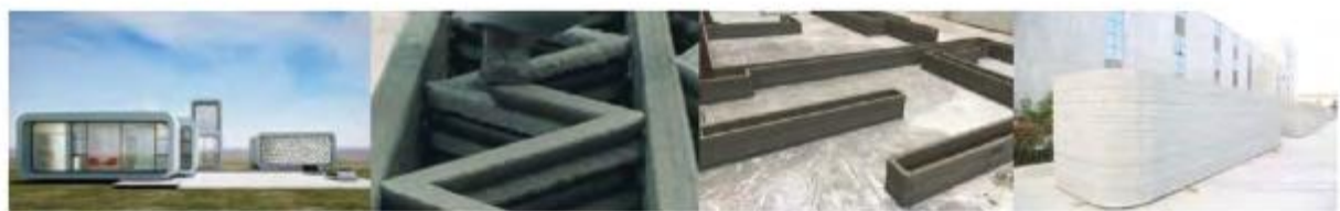
图纸深化 开始打印 打印墙体 墙体成品
